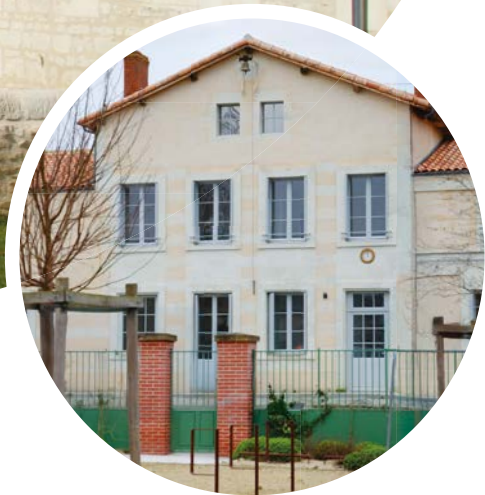
// Rénovation de l'ancienne école de garçons à Lenclôtre en logements
